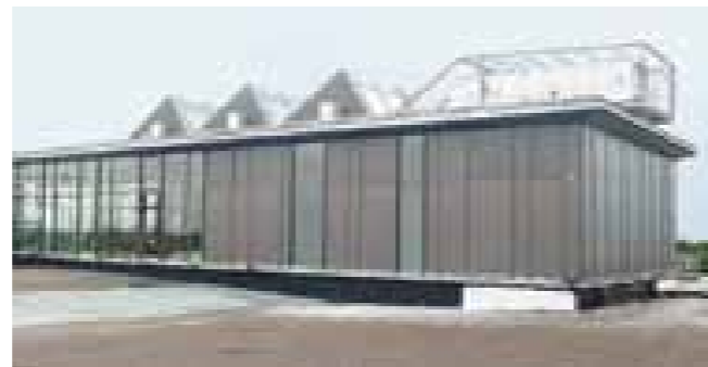
↑ Sanierungsprojekt Spinnerei Herding kurz vor Abschluss der Bauphase
